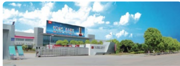
Завод в г. Ухань (5 млн. кондиционеров)
